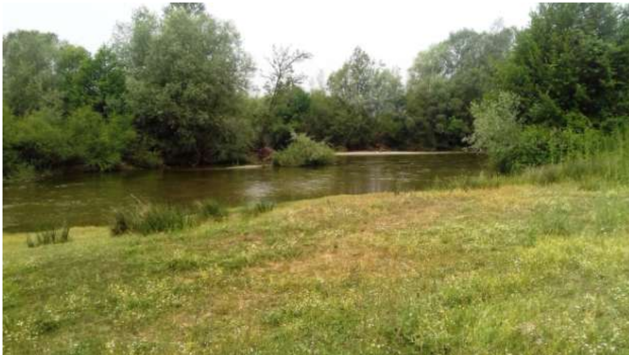
Εικόνα 2.1. Ανατολικό Ανάχωμα Νέστου .
